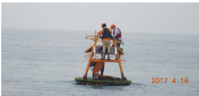
圖 4 台電離岸二期浮標維修
