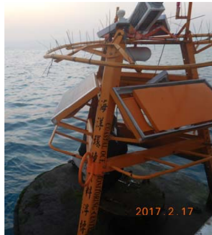
圖 6 台電離岸二期浮標太陽能板遭破壞脫落
