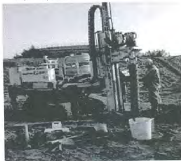
監測井設置(鑽井作業)
