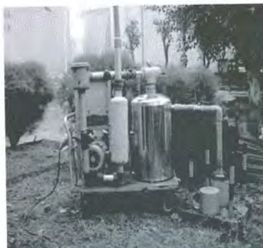
土壤油氣抽除工作(整治工作)
