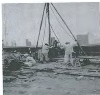
油槽基礎調查工作(鑽探採樣)
